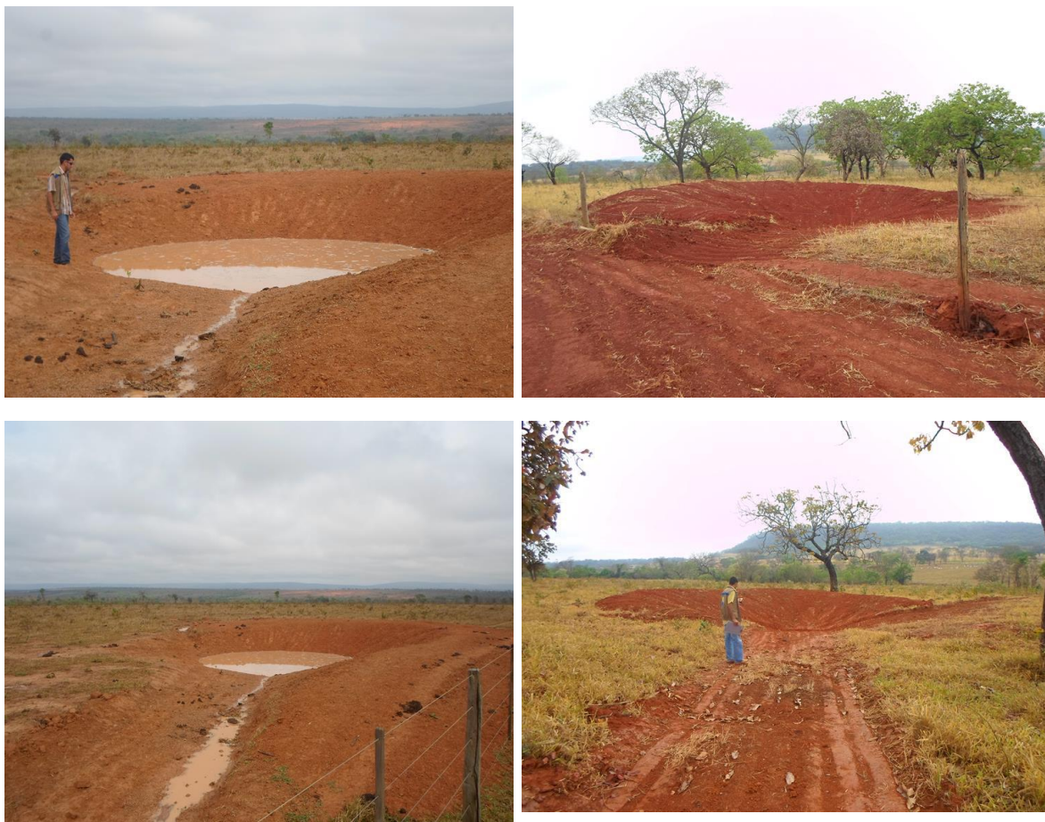
Figura 14: Barraginhas para coleta de enxurrada gerada em estrada rural
