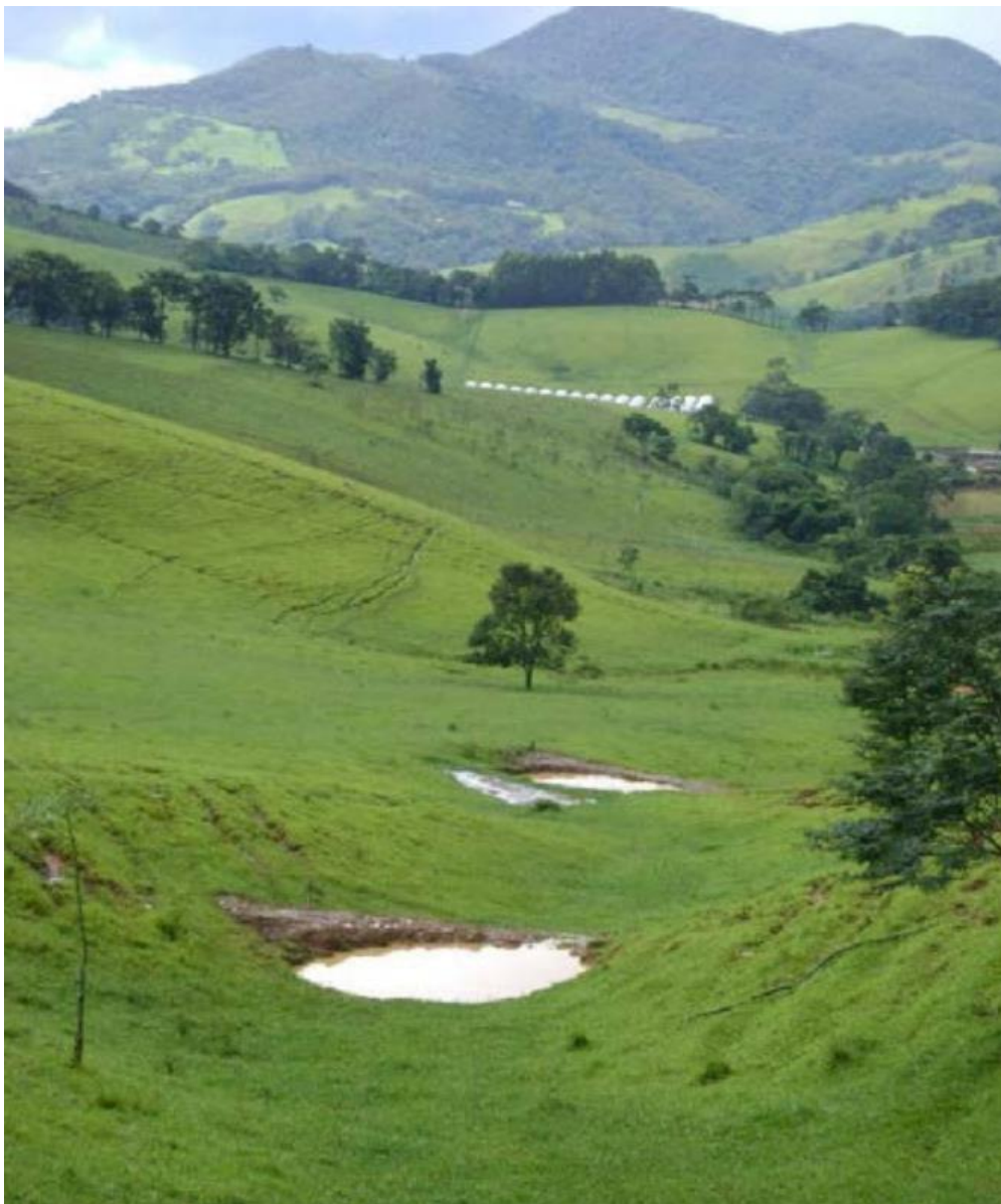
Figura 13: Barraginha construída em área de recarga de nascentes
