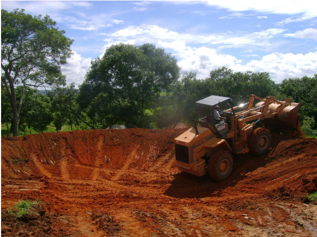
Figura 15: Pá-carregadeira durante a construção de uma barragem
