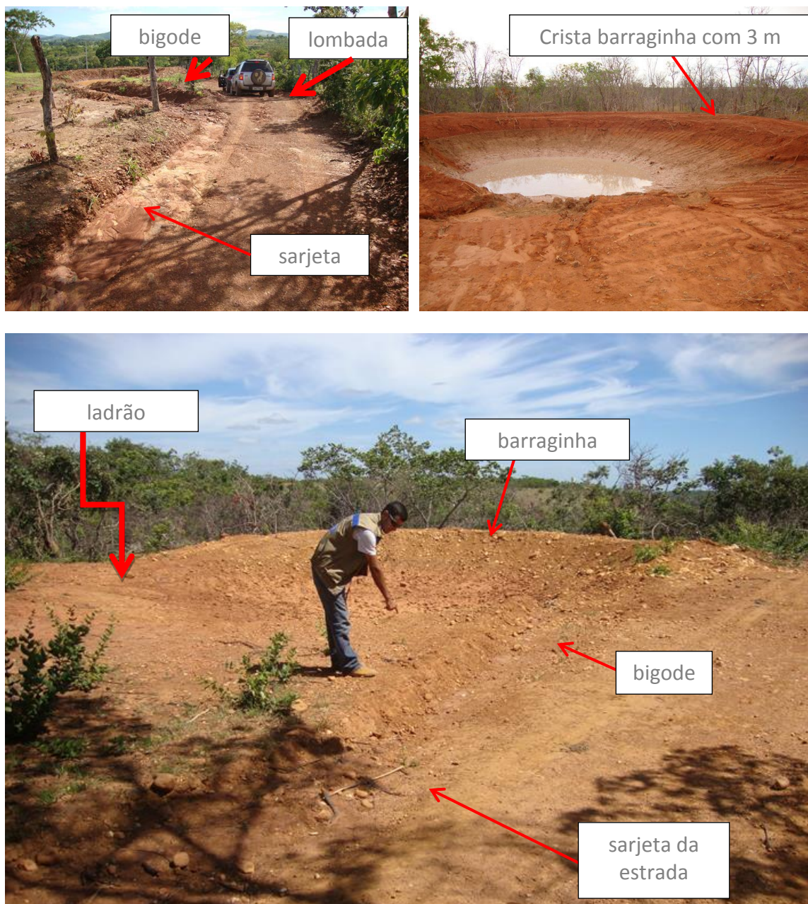
Figura 16: Barraginhas para coleta de enxurrada gerada em estrada rural
